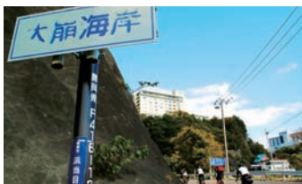
大崩海岸。看板の文字も崩れてました。
